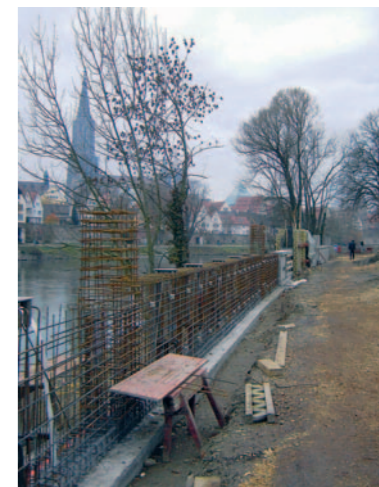
Die Hochwasserschutzmauer entsteht
