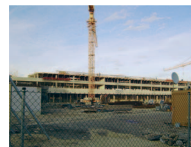
Der Rohbau der Fachhochschule
